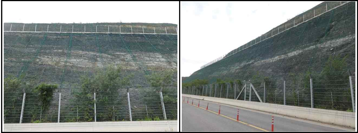
【그림 35.3.4】 보호/보강시설 전경
