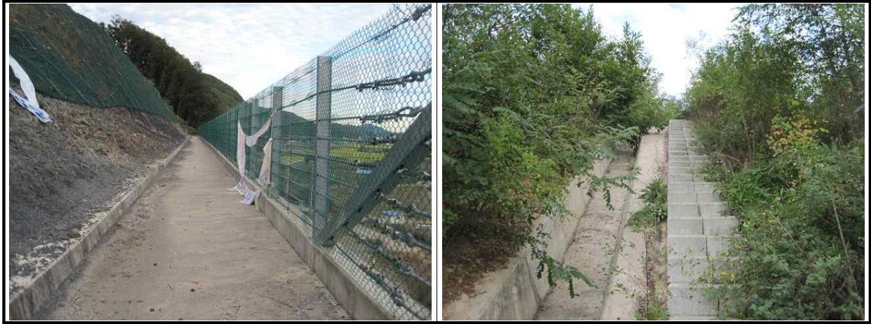
【그림 35.3.3】 배수시설 전경
